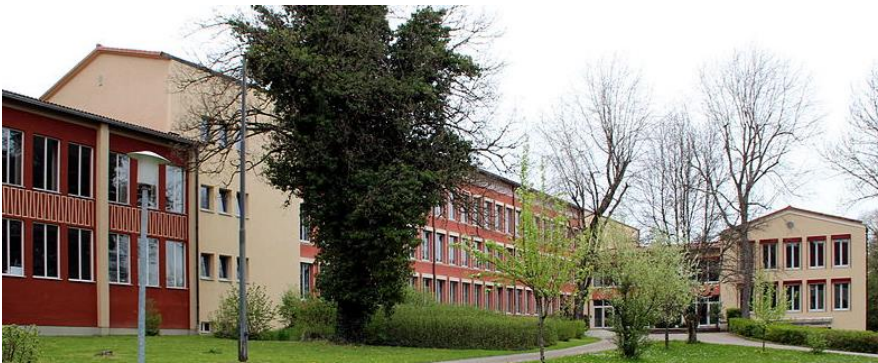
Abbildung 2 | Ansicht des Schulgebäudes mit den unterschiedlichen Gebäudeteilen (Quelle: Wikipedia)
